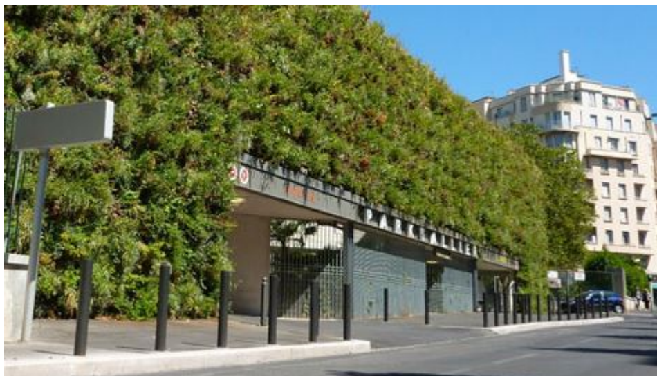
Bild: Ljuddämpande fasad utmed loftgång
