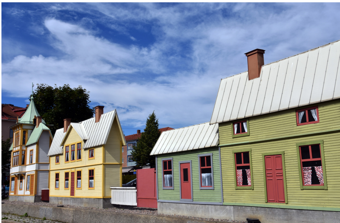
Klara Mors-kvarteret på Norra Järnvägsgatan i Ljusdal.
